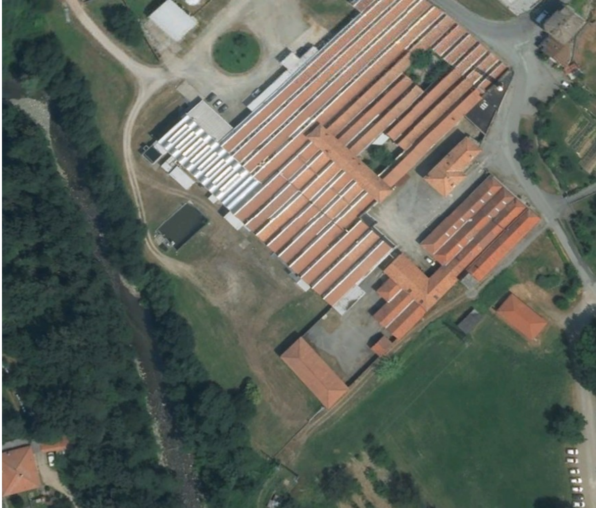
Vista aerea dell'area industriale
