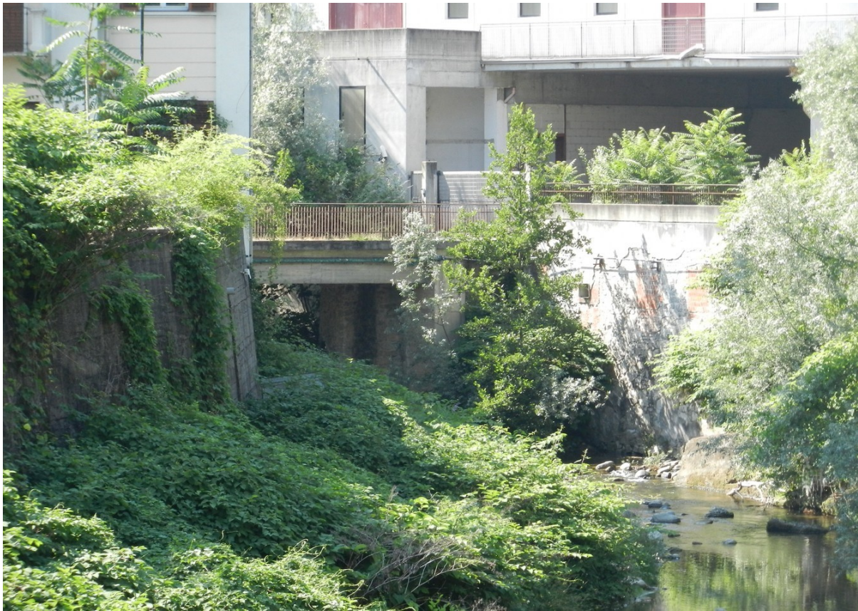
Ponte Lanificio di Lessona
