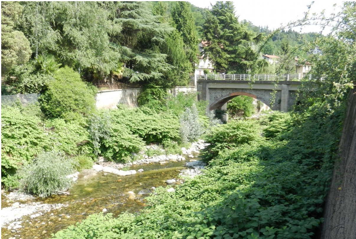
Ponte su strada provinciale
