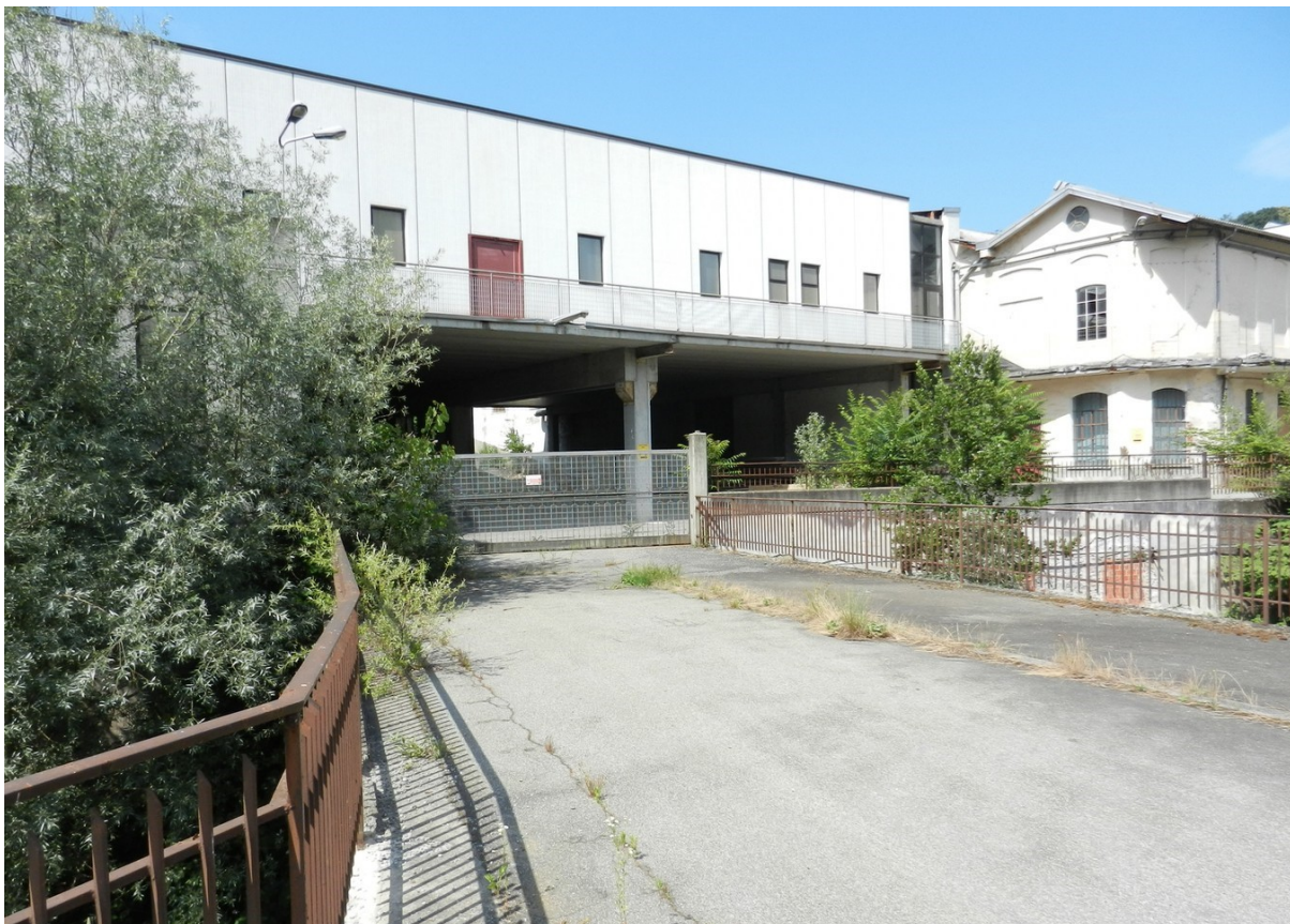
Lanificio di Lessona - Settore maggiormente interessato da esondazione
