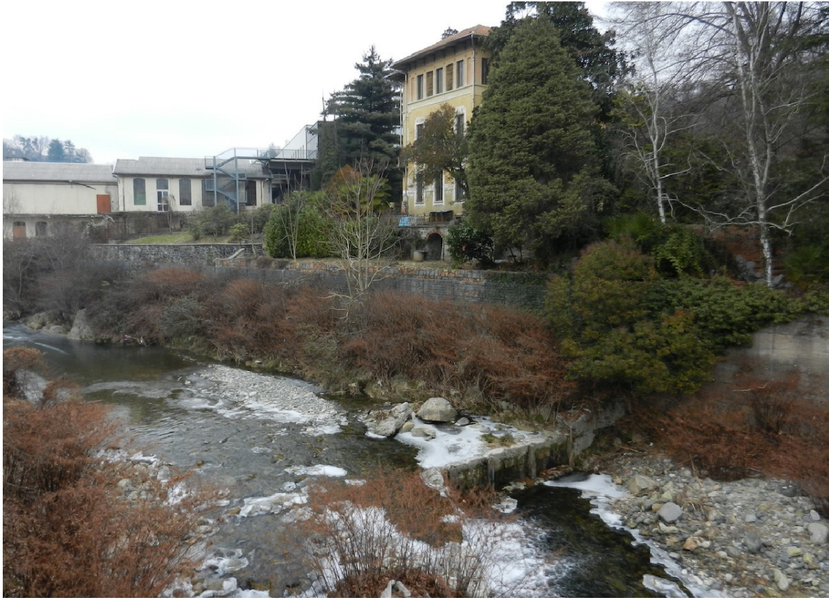
Edificio in esame
