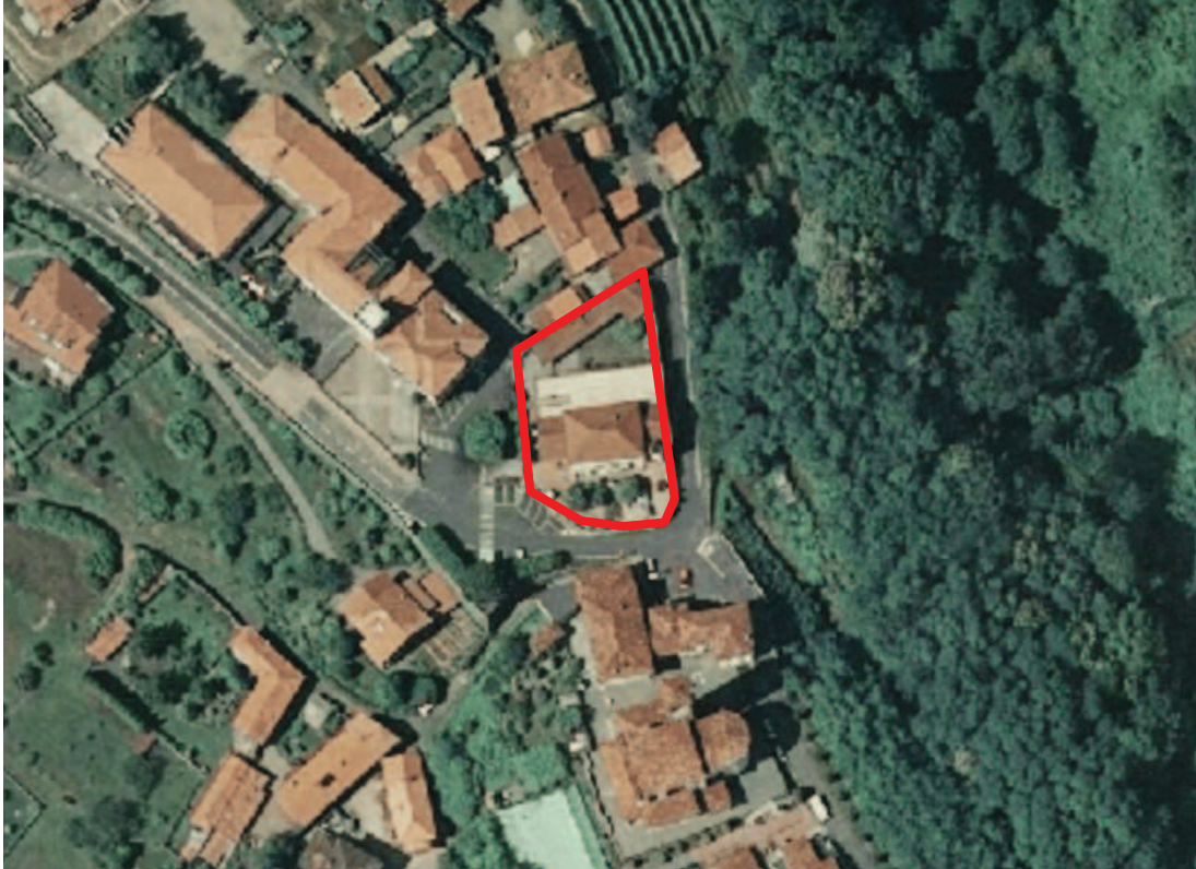
Vista di dettaglio del fabbricato oggetto d'intervento
