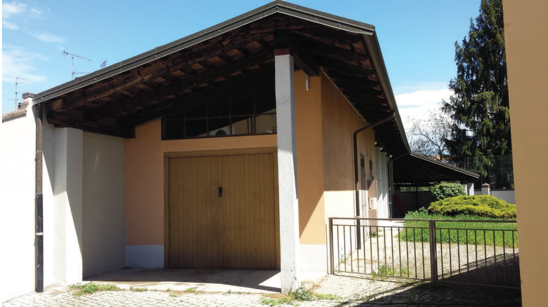
lato ovest - autorimessa
