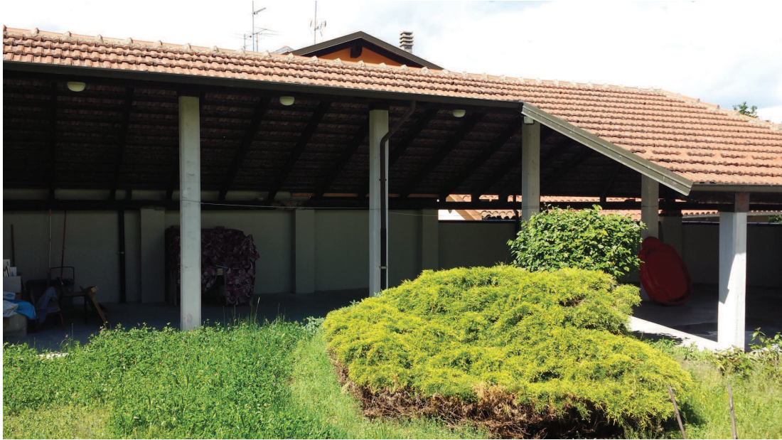
lato sud-ovest - porticato
