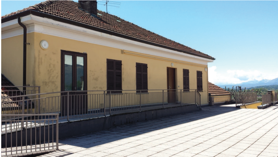
lato nord del corpo al primo piano, visto dal terrazzo
