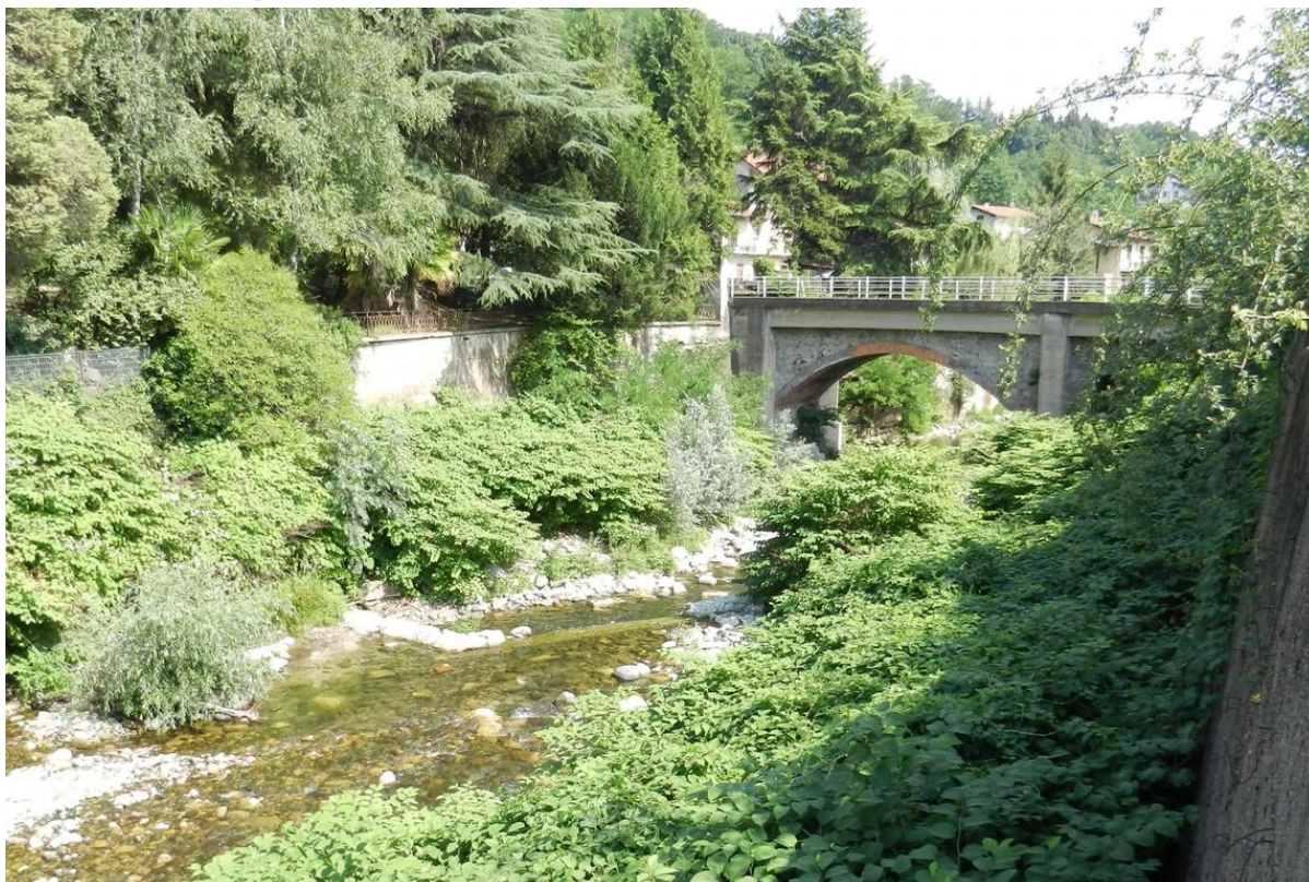
Ponte su strada provinciale
