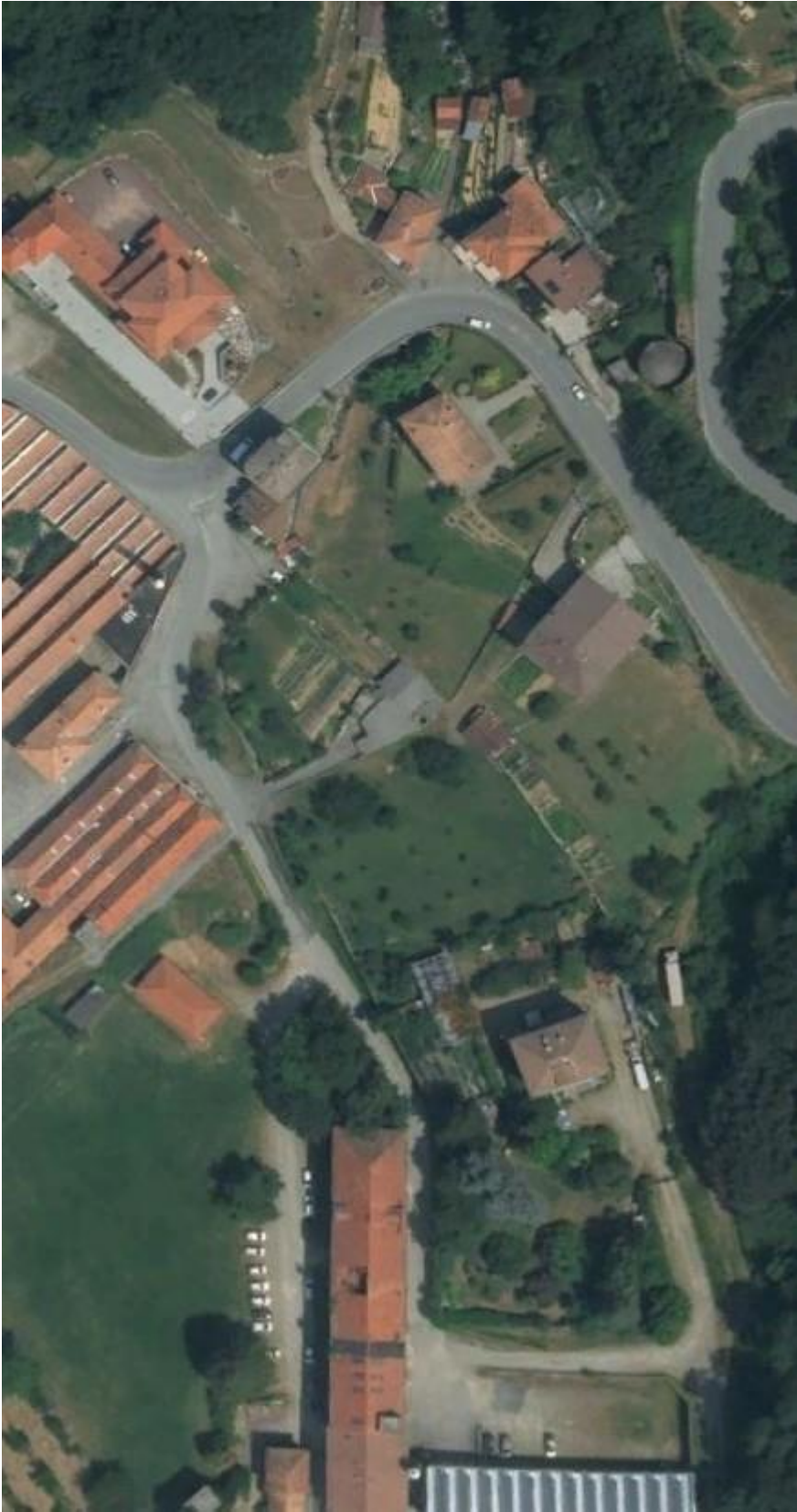
Vista aerea del tratto tombinato del rio Capovilla
