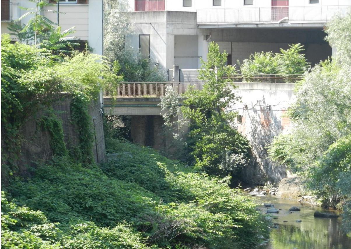
Ponte Lanificio di Lessona
