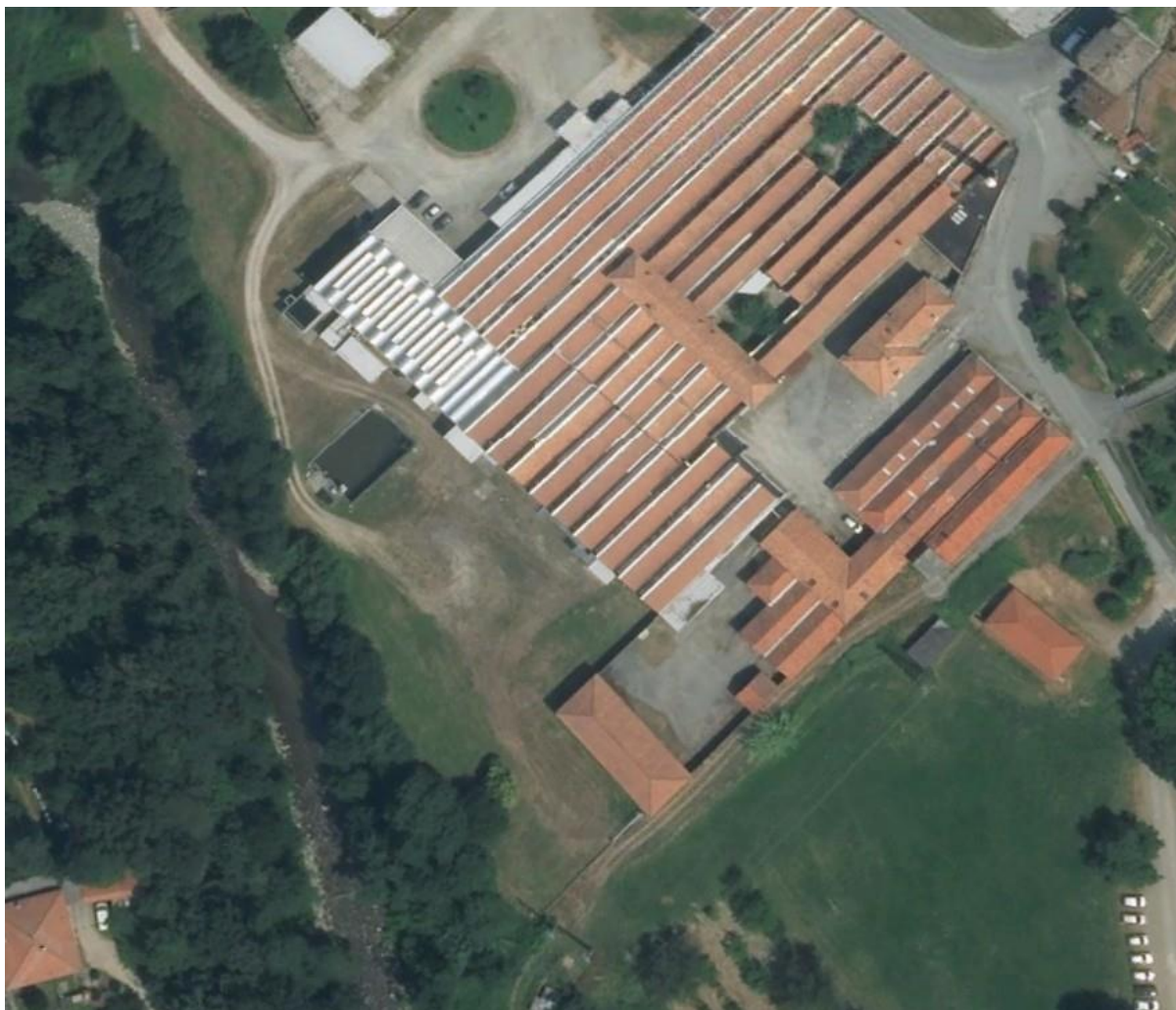
Vista aerea dell'area industriale
