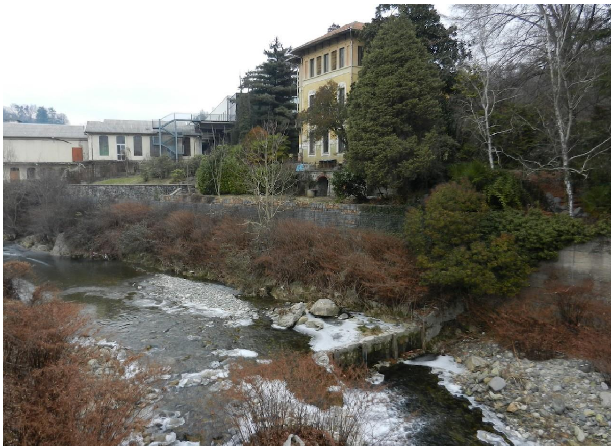
Edificio in esame
