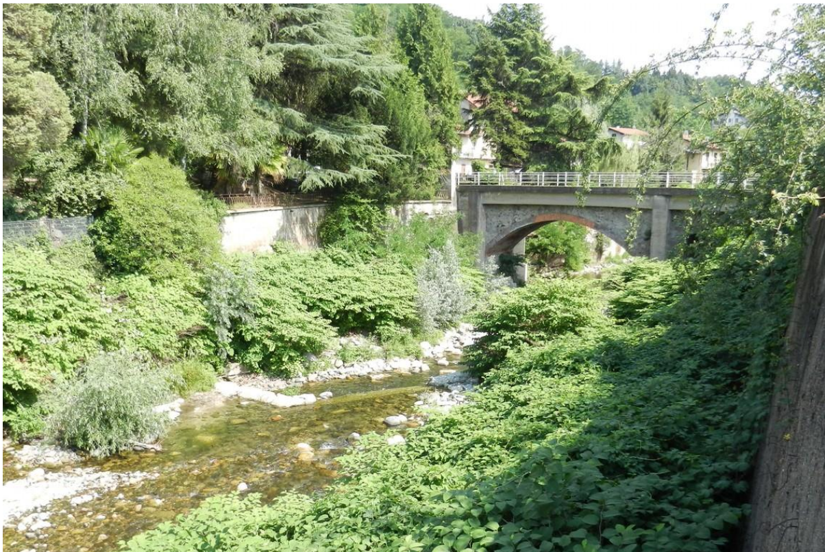
Ponte su strada provinciale
